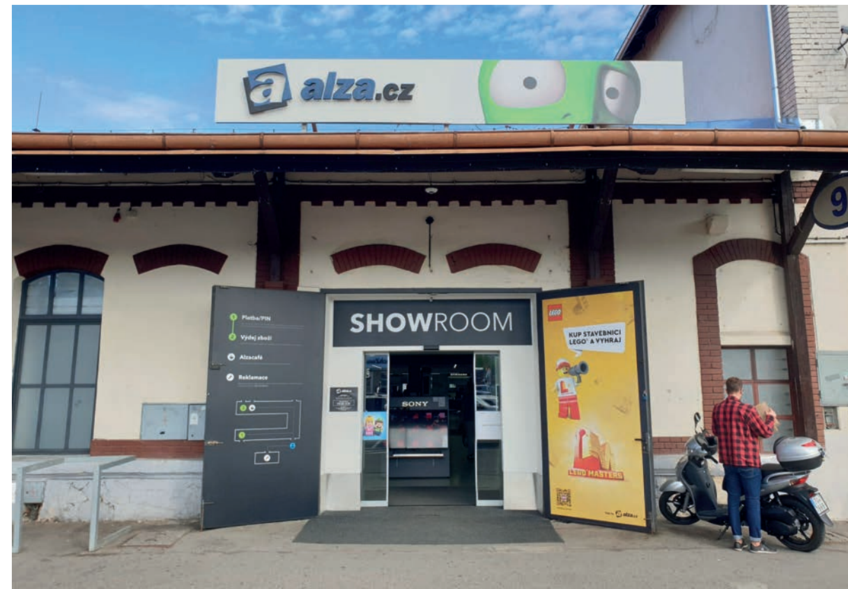
Stávající stav - fotografie provozovny prodejna Alza. Autor: Marek Skalský / Holešovická tržnice
