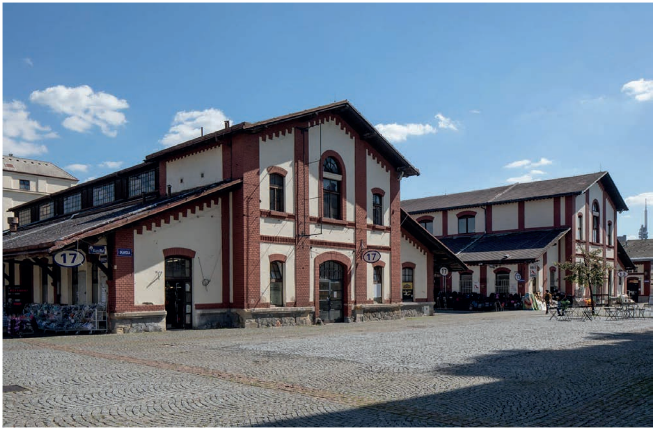
Stávající stav - fotografie provozovny prodejna Alza. Autor: Marek Skalský / Holešovická tržnice
