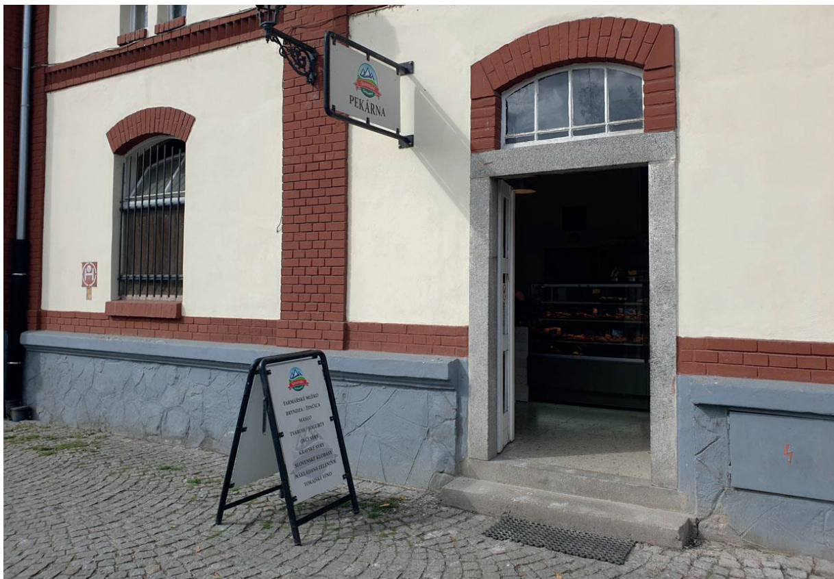
Stávající stav - fotografie provozovny prodejna Slovenské delikatesy Autor: Marek Skalský / Holešovická tržnice
